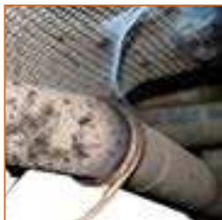
Do luzowania trudno dostępnych części poprzez zastosowanie specjalnego drutu nawojowego
