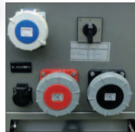
Panel sterujący dla opcji przełącznika w sieciach IT/TN
