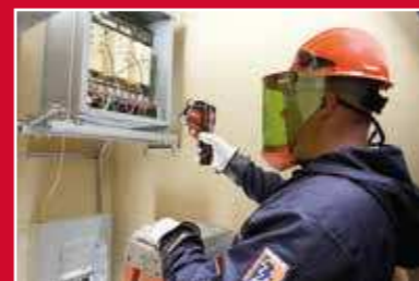
Aby zdiagnozować problemy z transformatorami
